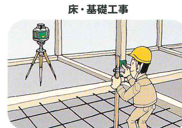
土台・床面のコンクリート打ちに。バカ棒に受光器を取り付けて一人でスムーズに水平出し。
